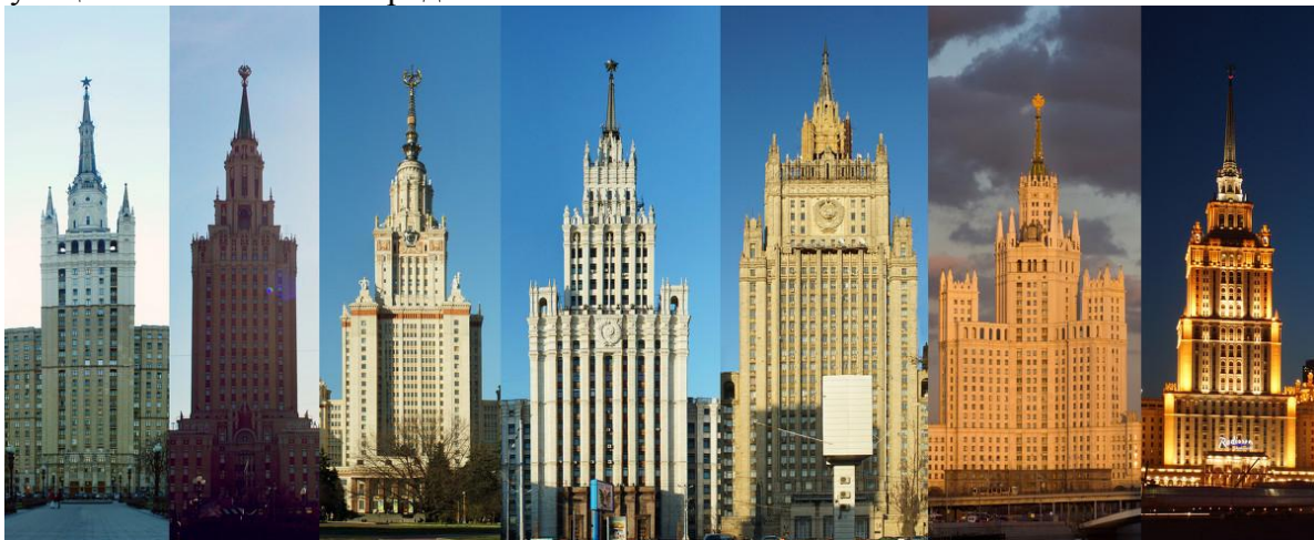
Рис. 2 Гостиница «Украина», жилой дом на Котельнической набережной, жилое здание на Кудринской площади, гостиница «Ленинградская», Министерство иностранных дел, главное здание МГУ, административно-жилое здание на площади Красных Ворот.
